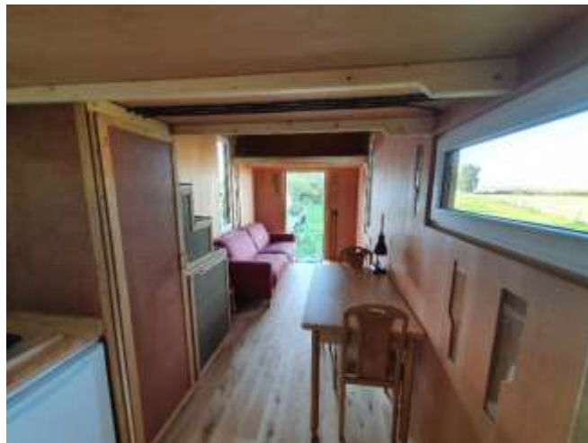
10 Blick von der Küche, rechts in der Wand sichtbar die kleinen „Dämmstofffenster“ (Foto: T. Galke)
