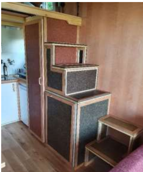
9 Schrank und Treppe aus Faserplatten aus Schilf und Seggen-/ Nasswiesenheu. (Foto: A. Nordt)
