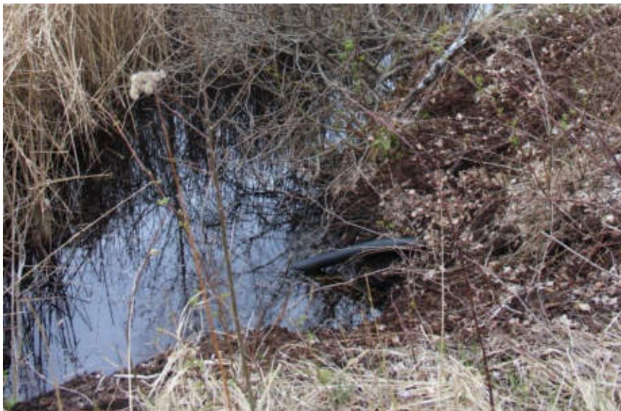
Рис. 15. Гофротруба закрытого дренажа на торфянике «Виттгирренское»
