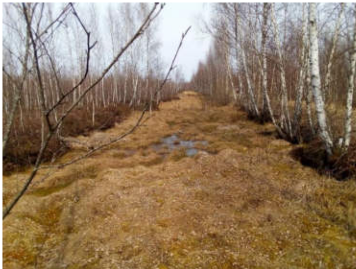
Рис. 13. Канал третьей категории с признаками заболачивания (зарастания сфагновыми мхами) на торфянике «Виттгирренское»
