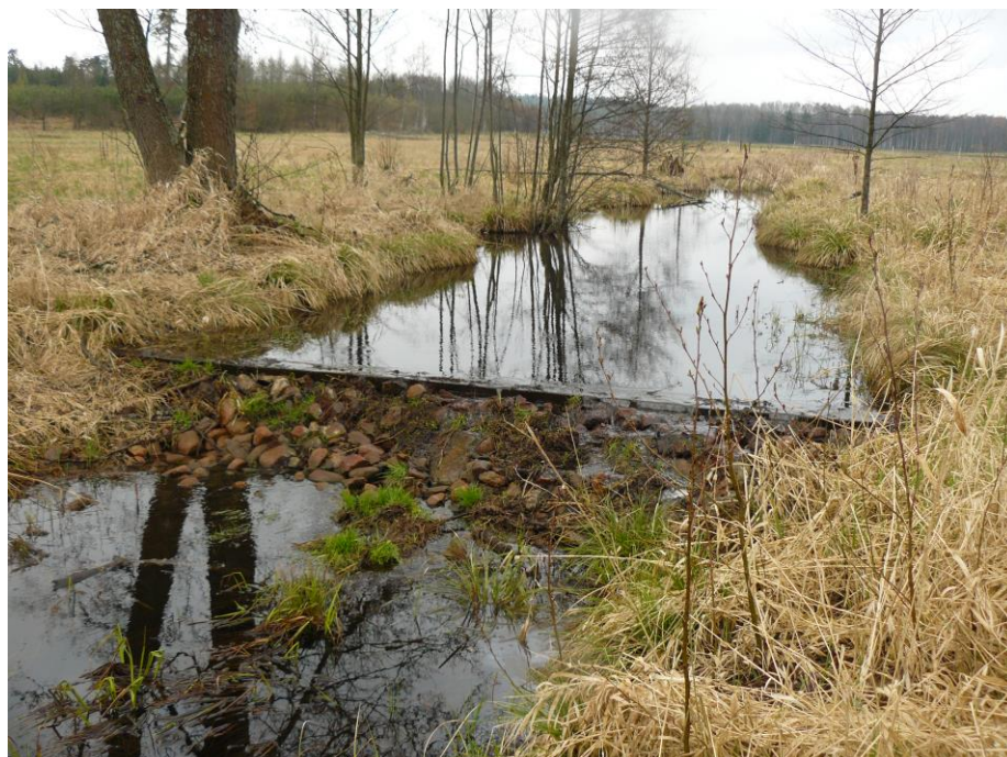
Zastawka, fot. Ł. Kozub
