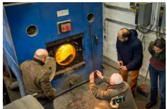
Abb. 1: Beispiele für die stoffliche (oben) und energetische (unten) Verwertung von Biomasse aus nassen Mooren (Foto oben: S. Melchior, Foto unten: T. Dahms)
